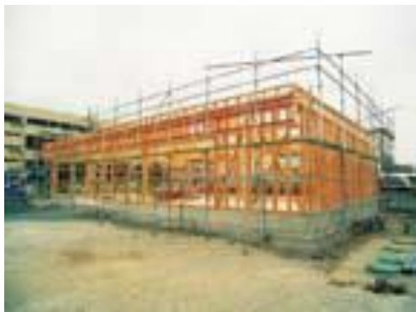
工事中の店舗
